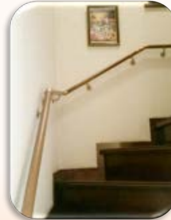
階段手すり取付け
